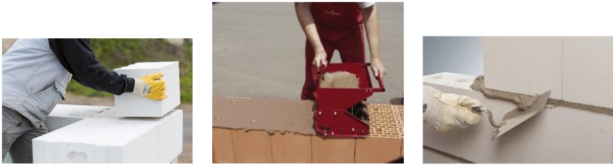
Bild 1-16: Beispiele für die Herstellung von Mauerwerk
