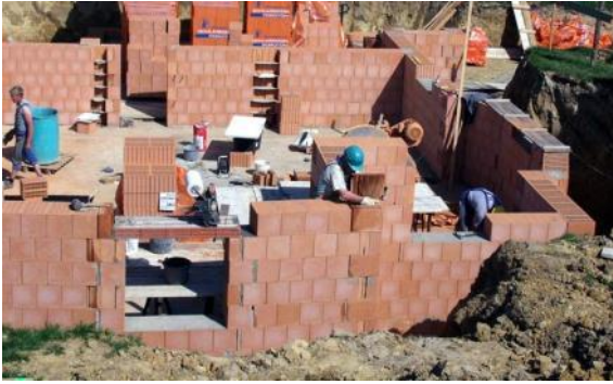
Bild 9-9: Blick auf den Bauzustand der Kellerwand ohne Verfüllung
