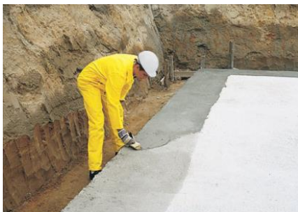
Bild 9-10: Abdichtung bei Sickerwasser
