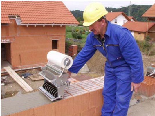
Abb.5.2-7: Auftrag DM mit Gewebezwiseilage.
