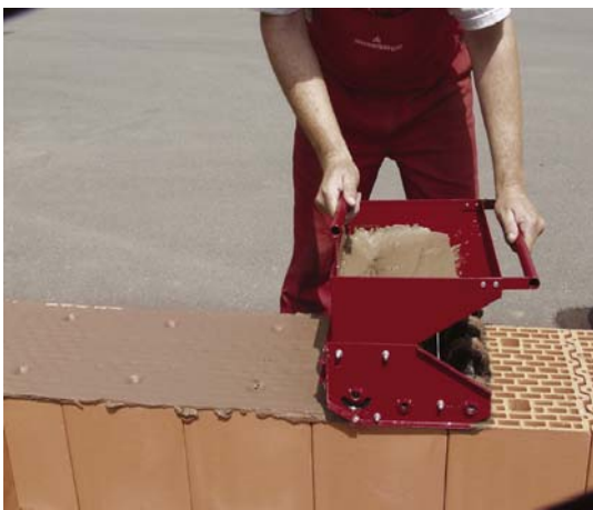
Abb. 5.2-8: Auftrag eines deckelnden DM.
