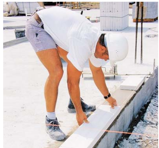
Abb. 5.2-9: Herstellung der ersten Schicht, aus [2].
