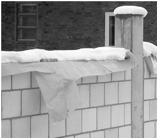
Abb. 5.2-11: Frisches Mauerwerk ist vor übermäßiger Durchfeuchtung und Frost rechtzeitig zu schützen, z. B. durch Abdecken mit Wärmedämmmatten, aus [4].
