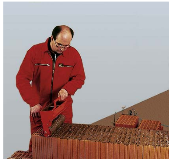
Abb. 5.2-6: Auftrag DM mit Rolle.
