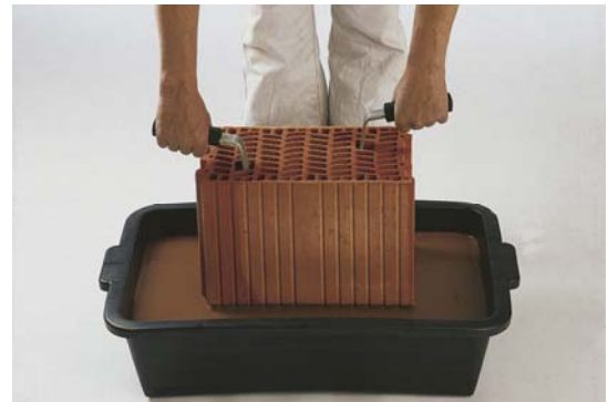
Abb. 5.2-5: Auftrag DM mit Tauchverfahren.
