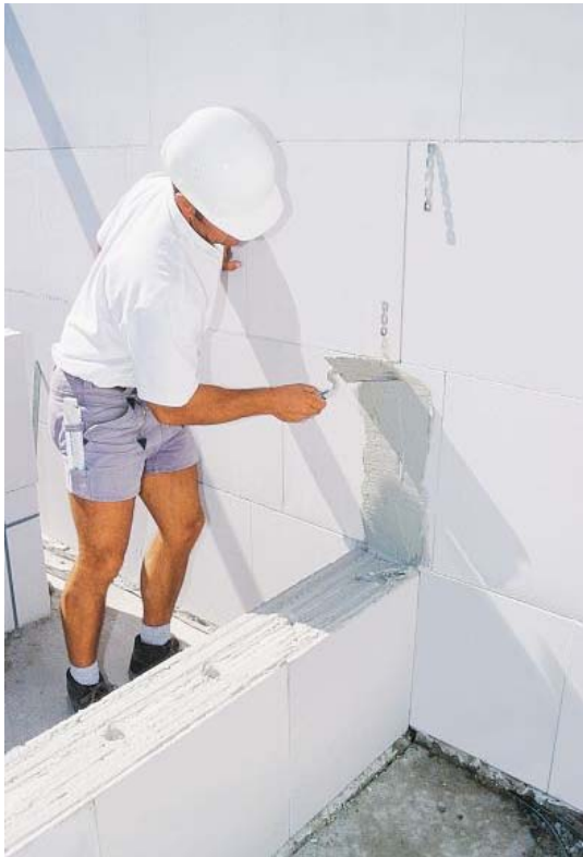
Abb. 5.2-3: Mörtelauftrag mit der Kelle (hier zur Vermörtelung des Stumpfstoßes), aus [2].
