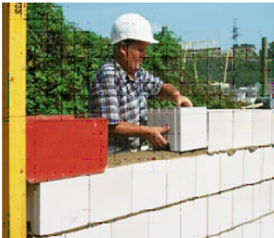
Abb. 5.2-1: Verarbeitung von Hand mit Normalmörtel, aus [2].
