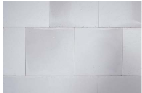
Abb. 5.1-1b: Mauerwerk aus Kalksandsteinen und Dünnbettmörtel.
