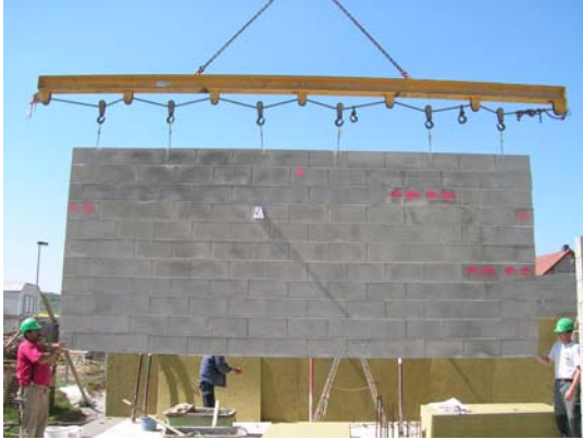
Abb. 5.1-3: Werksgefertigte Mauertafel, Betonsteinmauerwerk (Beispiel)
