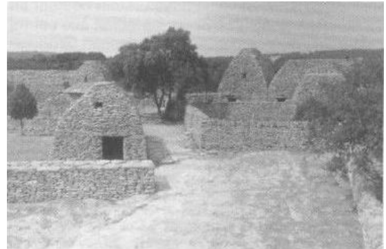
Abb. 2.1-1: Archaische Mauerwerkskonstruktion im besten Sinne primitiver Technologie: Le Village Des Bories, Gordes, Südfrankreich.
