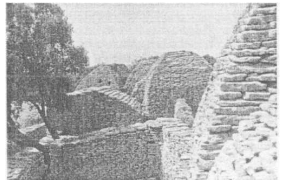
Abb. 2.1-2: Bories, errichtet aus vor Ort gefundenen und ohne Mörtel geschichteten Steinen.
