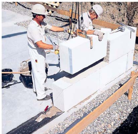
Abb. 4.2.4-5: Versetzen von Porenbetonplanelementen mit dem Versetzgerät, aus [1].
