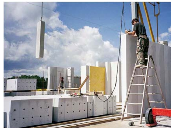
Abb. 4.2.4-6: Versetzen geschosshoher Wandtafeln, aus [1].
