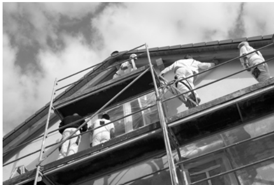
Abb. 4.1.3-8: Aufbringen eines Unterputzes auf eine Wand (re.) und anschließendes Abziehen mit der Kartätsche (li.) (Foto: Knauf Marmorit GmbH).
