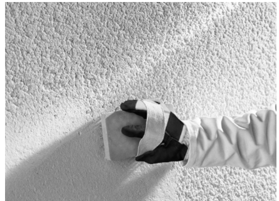
Abb. 4.1.3-3: Durch das nachträgliche Kratzen mit dem "Kratz-Igel" erhält der mineralische Edelputz seine klassische Kratzputzstruktur (Foto: quick-mix).
