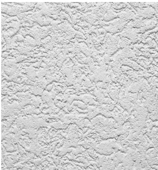
Abb. 4.1.3-5: Als Reibeputz (mit Rillenstruktur) ausgeführter mineralischer Edelputz (Foto: Saint-Gobain Weber GmbH).
