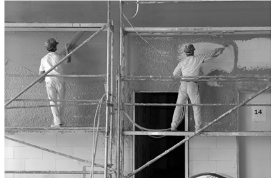
Abb. 4.1.3-9: Verputzen von hochwärmgedämmendem Mauerwerk mit einem mineralischen Edelputz (Foto: maxit Deutschland GmbH).
