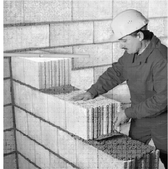
Abb. 4.1.2-1: Vermauerung von Leichtbetonsteinen mit Leichtmauermörtel LM 21 (Foto: Dennert Poraver GmbH).
