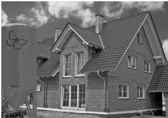
Abb. 4.1.2-3 Mauerwerk stellt einen idealen Putzgrund dar, wenn es fachgerecht und mit dem richtigen Mauermörtel vermauert wurde (Foto: Wienerberger Ziegelindustrie GmbH und IWM).
