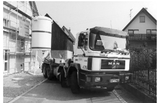
Abb. 4.1.1-1: Anlieferung von Werk-Trockenmörtel im Silo auf die Baustelle (Foto: maxit Deutschland GmbH).
