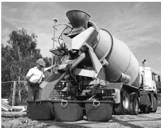
Abb. 4.1.1-2: Anlieferung von Werk-Frischmörtel im Fahrmischer auf die Baustelle (Foto: Heidelberger Beton GmbH).
