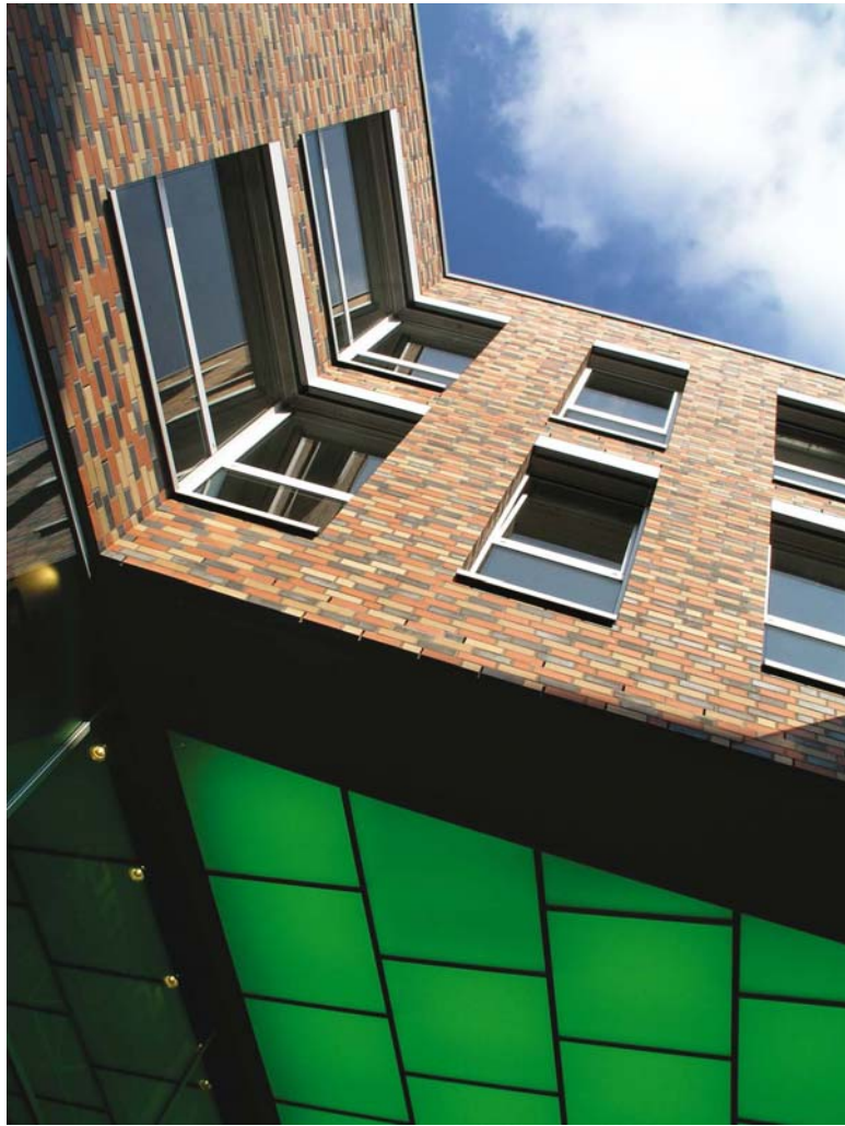
Eckansicht der Kamp-Promenade mit interessanten Fensteranordnungen im Kontrast zur farbig nuancierten Verblendklinker-Fassade
