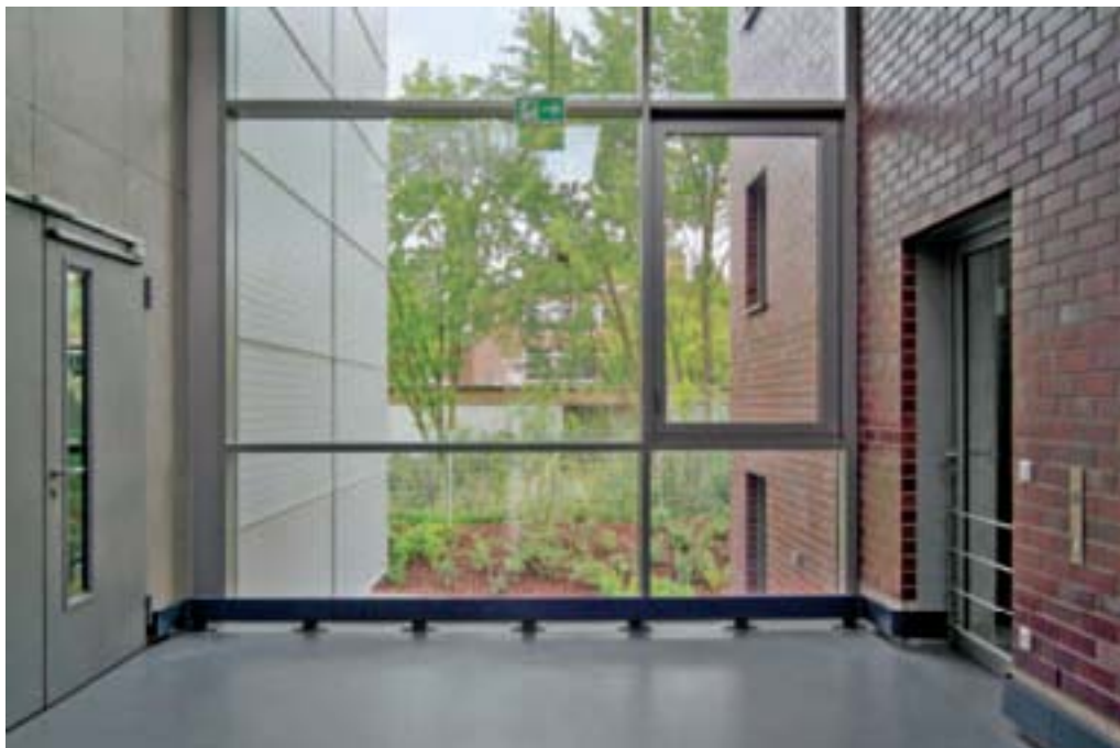
In Teilbereichen haben die Architekten die Vorsatzschale der Außenhaut auch im Werkstattinnern fortgesetzt. Die hohe Materialgüte des Klinkers eignet sich dabei auch ohne Rammschutz als robuste Innenwandverkleidung.
