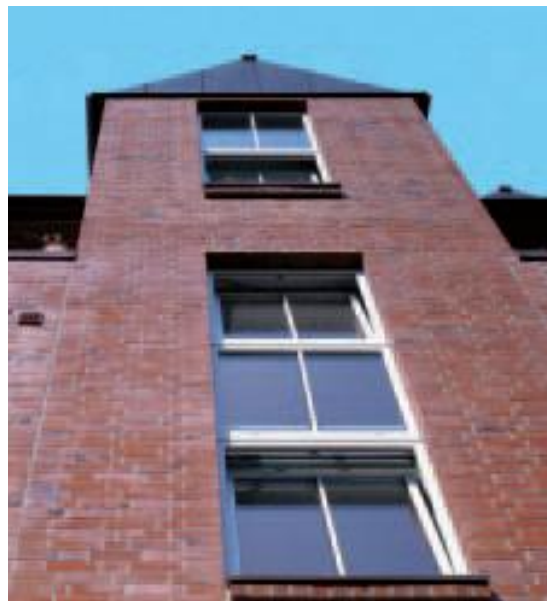
Die bunten kohlegebrannten Klinker aus bestem Rheiderländer Ton tragen entscheidend bei zum Brückenschlag zwischen jahrhundertalter Hamburger Wohnkultur und heutigen Komfortansprüchen. Elemente wie die Giebelfassade zitieren charmant die Handelskontore hanseatischer Patrizierfamilien
