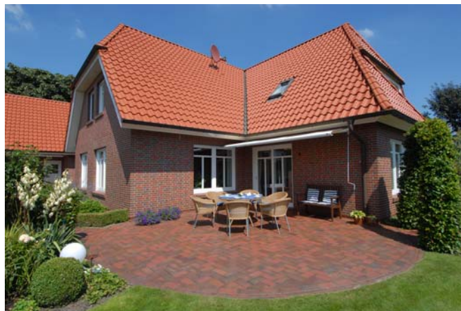
Rückansicht auf die Terrasse
