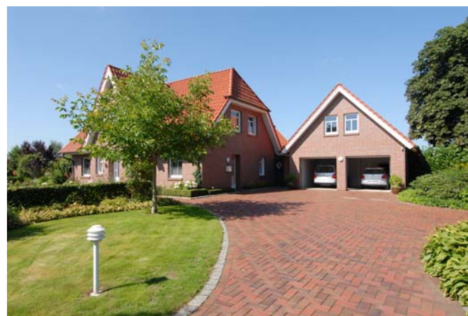
Ansicht auf die Auffahrt und Garage
