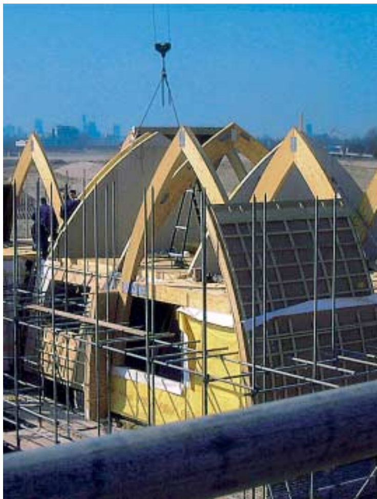
Außergewöhnlich: Die Holzskelett-Konstruktion mit gerundeten Sparren und der zusätzlichen Sperrschicht aus Hartfaserplatten
