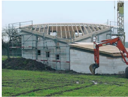
Nordansicht mit deutlich erkennbarer Dachkonstruktion: Brettschichtholz 6/40 cm
