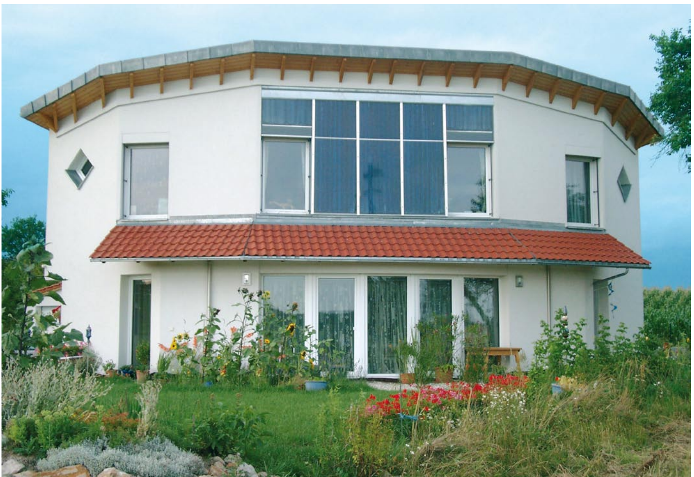
Südsicht: Alle Aufenthaltsräume sind segmentbogenförmig nach Süden geöffnet
