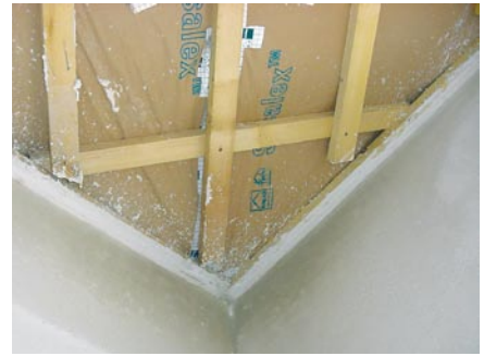
Anschluss der Außenwand zum Dach auf der Nordseite
