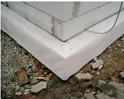
Wärmebrückenfreie Ausführung des Details Bodenplatte – aufgehende Wand
