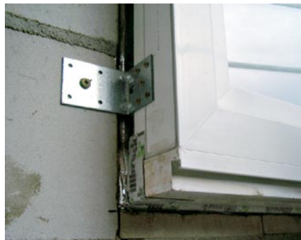
Fensteranschluss vor Anbringen des WDVS
