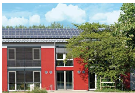
Photovoltaikanlage auf dem Seminargebäude
