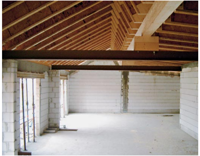
Dachgeschoss des Seminar- und Verwaltungsgebäudes im Rohbau
